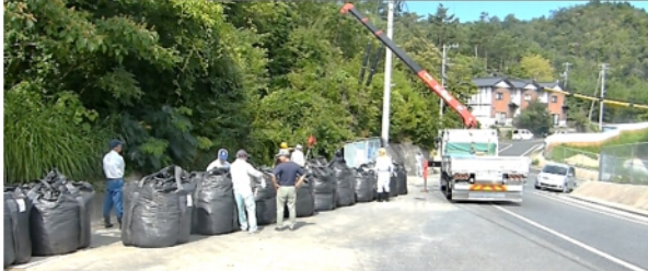
宗吉土石流の2カ所の開口部に土のうを設置
