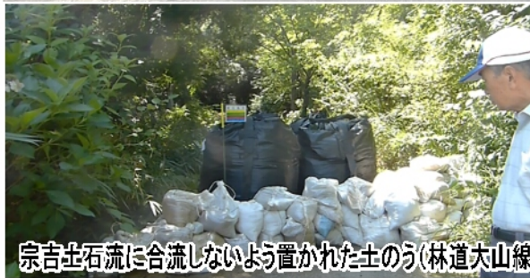
宗吉土石流の2カ所の開口部に土のうを設置
