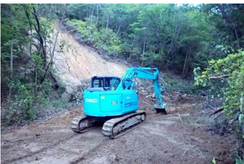
【重機が土をはぎとる】
