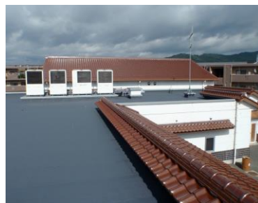
屋上の防水工事 (7.8月)
