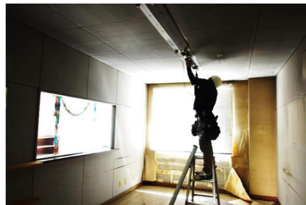
各室内の照明器具の撤去、主電源、通電停止作業
