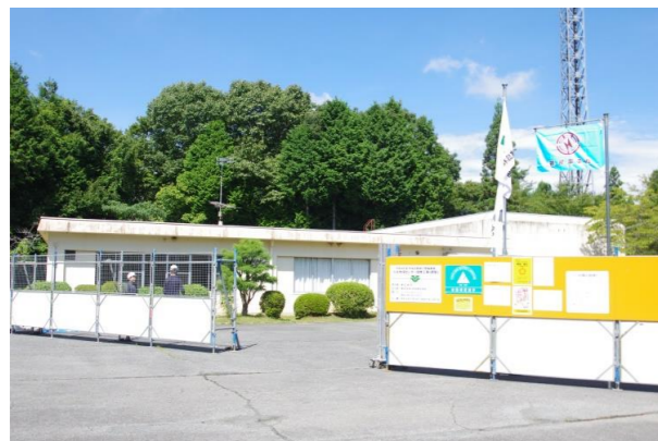
請負業者の社旗と安全確認等の掲示
