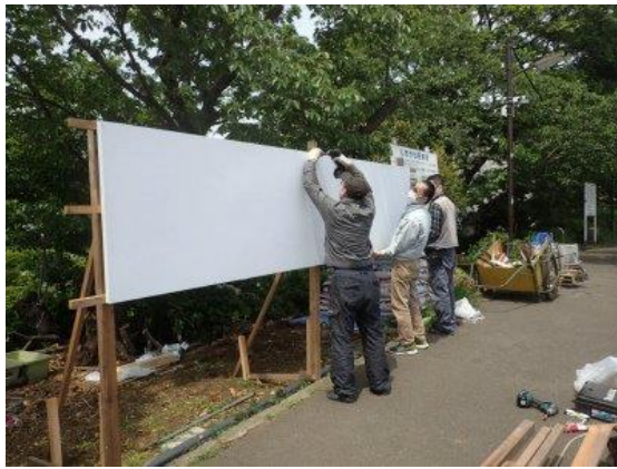
受付横の看板整備
