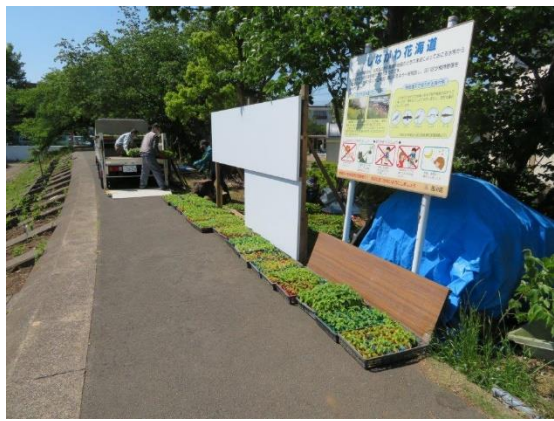
西岸二次荷卸し完了・仮置き
