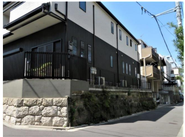
南品川石積護岸跡
