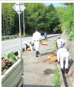
【側溝の土砂撤去】
