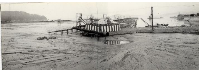
③ 木工団地建設の起工式(昭和42年)
