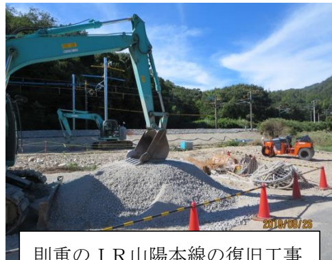
則重のJR山陽本線の復旧工事
