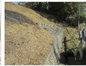
③ 溜池堤体修復状況
