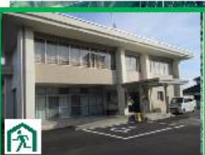
⑮ 高屋東地域センター 第一避難所
