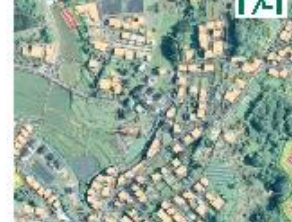
⑥ 住宅裏斜面崩壊
