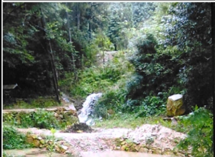
曾場ヶ城山溪流からバイパス側道へ出水(瀧の谷馬頭神社) 治山ダム工事予定箇所 8月13日10時55分
