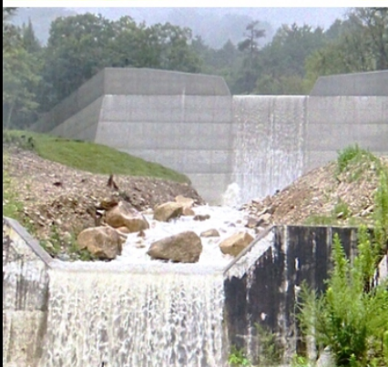
曾場ヶ城山溪流(三反田川)の治山ダム土砂災害警戒区域NO8 14日6時00分 高さ10.7mの治山ダムにより道路への出水なし
