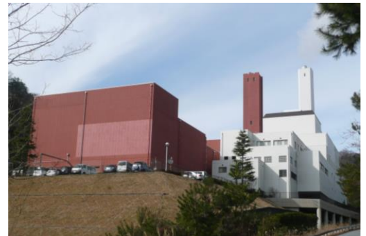
賀茂環境衛生センター(上三永)
