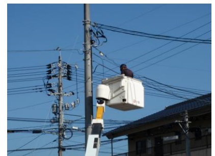
《ケーブル接続作業 9/10》
