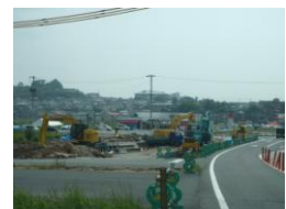
《国道375号線工事》
