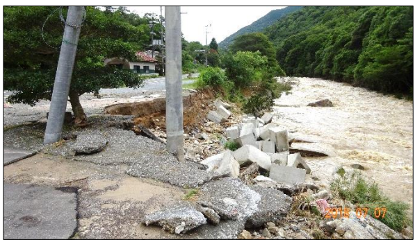
河川の氾濫による堤防の決壊 関川発電所付近
