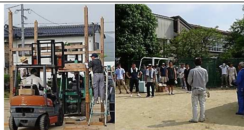
【櫓などの組立て設営完了-7月30日】
