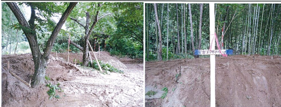
堤防復旧工事中
