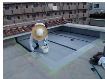
《防水シート貼り付け工事》
