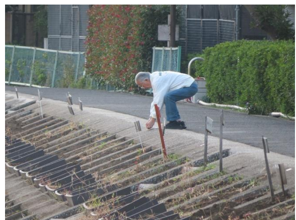
ブロック番号貼付作業
