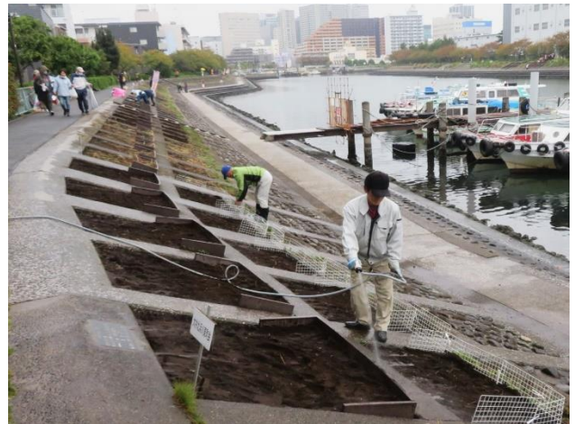
仕上げの散水作業
