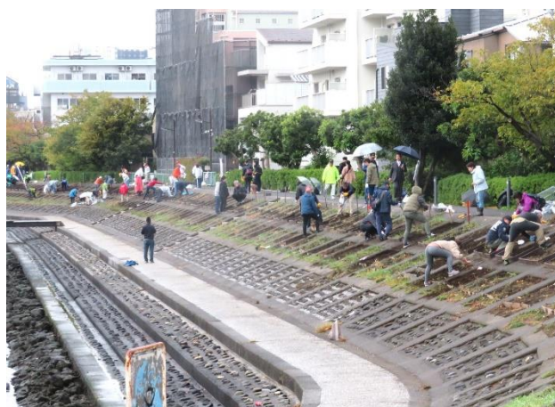
西護岸側作業風景
