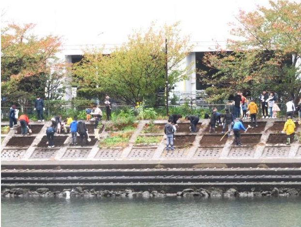
勝島側全体作業状況
