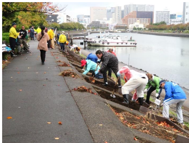
西護岸側作業風景
