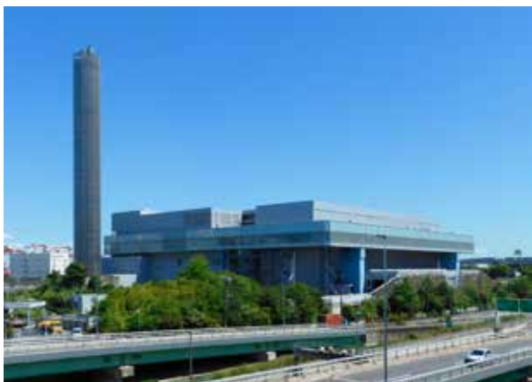
品川清掃工場全景
