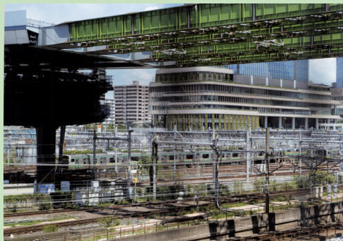
土が運ばれたのはこのあたり？ （高輪ゲートウェイ駅付近の車両基地）
