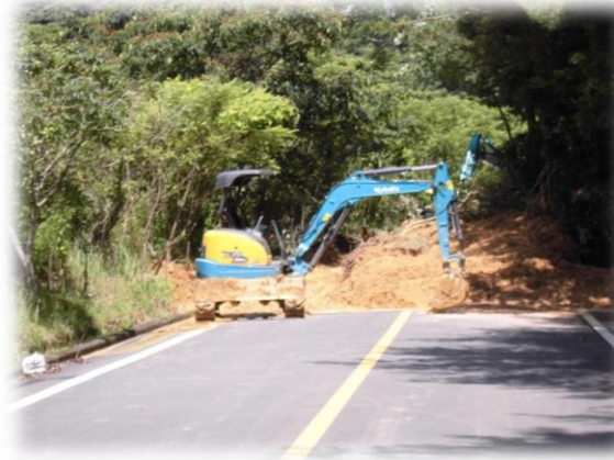
国道432号(河内IC～竹原新庄間)
