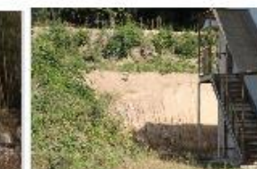
㉜家の裏土砂崩れ
