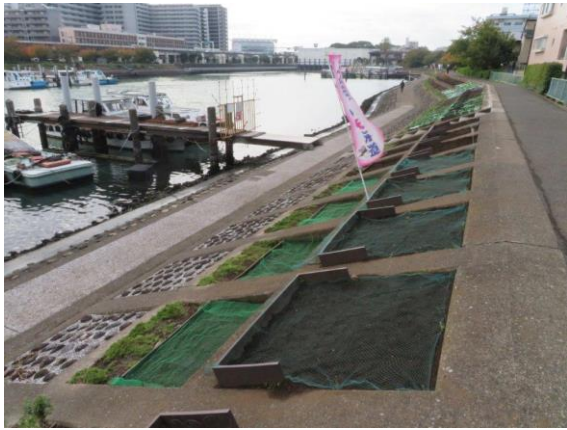
初日種まき完了姿(ネット養生エリア)
