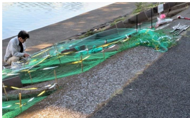
町会エリアでのネット養生追加作業
