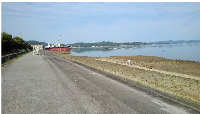
写真1. プロジェクト対象の干潟. 階段状の護岸整備がされており, 背後に松並木がある.
