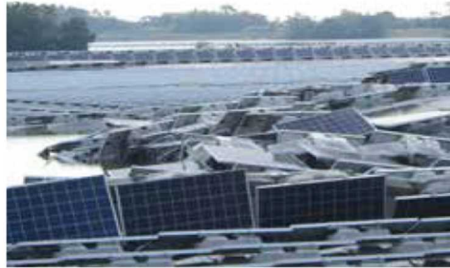
千葉県市原市水上設置型太陽光発電所損壊 (2019年9月台風)
