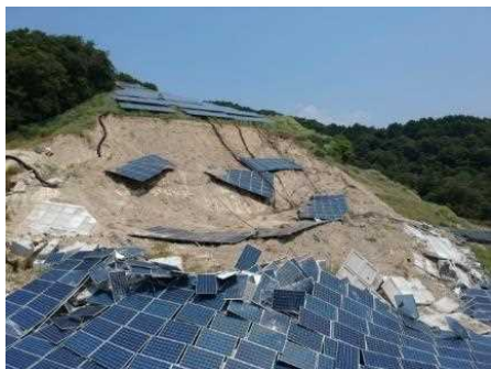
土砂崩れで生じた崩落
