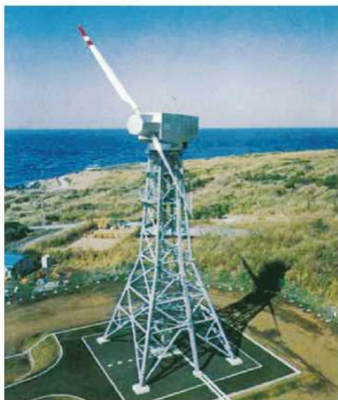
100kW級風力発電実験機（東京都三宅島）
