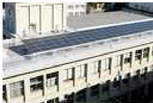
公共施設屋根設置
