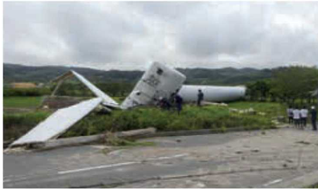
兵庫県淡路市風力発電設備倒壊 (2018年8月台風)
