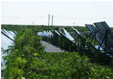
放置されたパネルの現況
