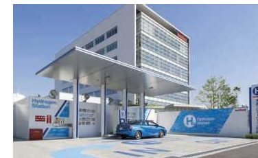
水素ステーション
