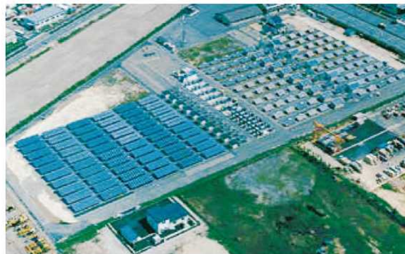
六甲新エネルギー実験センター（兵庫県神戸市）
