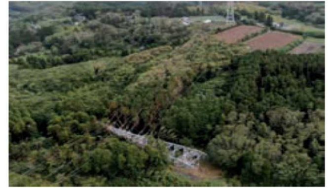
千葉県君津市送電線鉄塔倒壊 (2019年9月台風)
