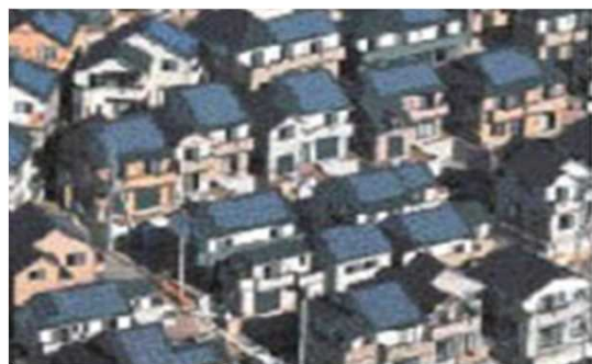
住宅屋根設置
