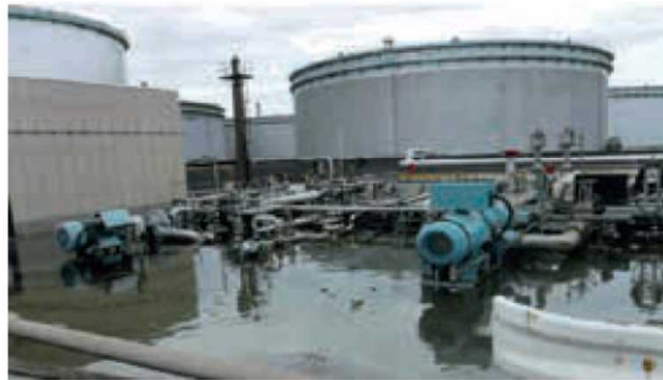
冠水した製油所敷地 (2019年10月台風)
