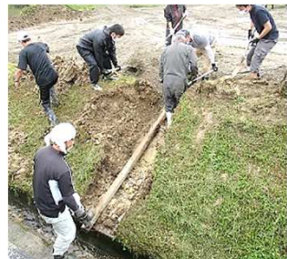
学校南側に駐車場を整備 水抜き管路を埋設
