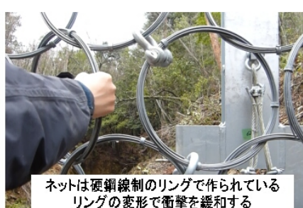
上部の横の張られたワイヤー(ネットが吊るされている)衝撃を吸収する多数のプレーキリングの中を通されている
