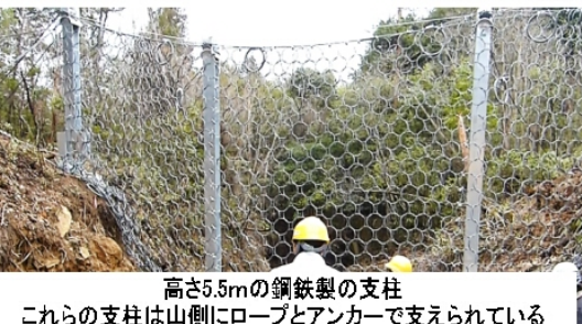
支柱が固定された基礎部分(手前に3m、奥に5.5mのアンカーで固定)
