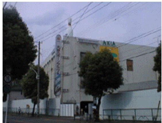
平成12年(2000)6月 解体前
