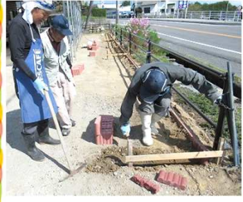
【花壇部分の工事】
