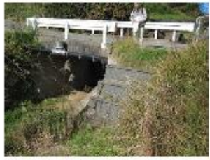
②橋台部が崩壊。対策工事後状況
