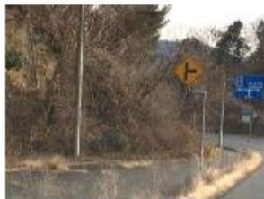
⑱斜面が崩れた
