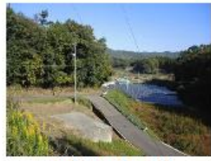
⑨水路に落ち葉がたまり水が溢れる
