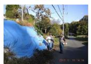
⑮畑のり面が崩れた
