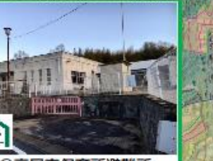
④高屋東保育所避難所
