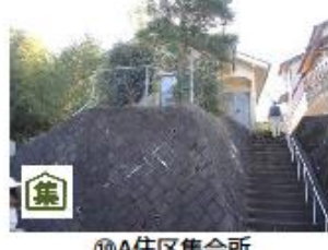
⑩A住区集会所 石段がずれている
