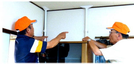
高さの高い家具は天井にポール式床にマット式器具を併用
