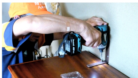
高さの低い家具はL型金具で壁に固定
