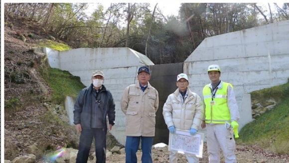
高垣市長(左から2人目)と八本松住民自治協関係者 背景 溝迫交差点上流の曾場ヶ城山渓流に完成した治山ダム このダムの上流に更に4基の治山ダム建設が計画されている
