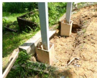
看板設置状況（左：穴掘り 中：支柱基礎工 右：完成）(H28.6.26)
