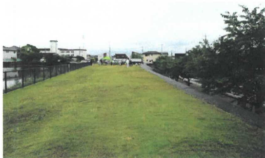
作業終了の状態
