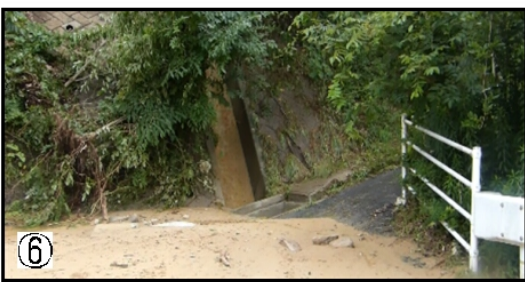
⑥ 国道バイパス5号横断橋にある土石流開口部
