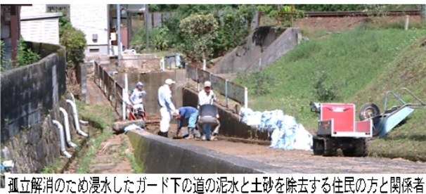
孤立解消のため浸水したガード下の道の泥水と土砂を除去する住民の方と関係者
