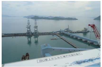
2・3号揚炭岸壁（屋上より）
