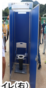
マンホールトイレ構造図(左)/設置した仮設トイレ(右)
